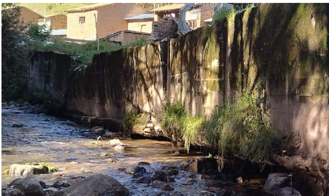
FIGURA N° 01: TRAMO CRÍTICO, MURO DE PROTECCION DE CONCRETO ARMADO SOCAVADO PARA DEMOLICION DE 110.00 m EN EL TRAMO 3
