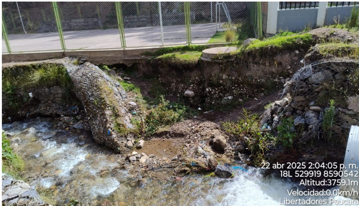
FIGURA N° 02: MURO CON GAVION DESPLOMADO POR SOCAVACIÓN PARA DEMOLICION DE 590.00 m
