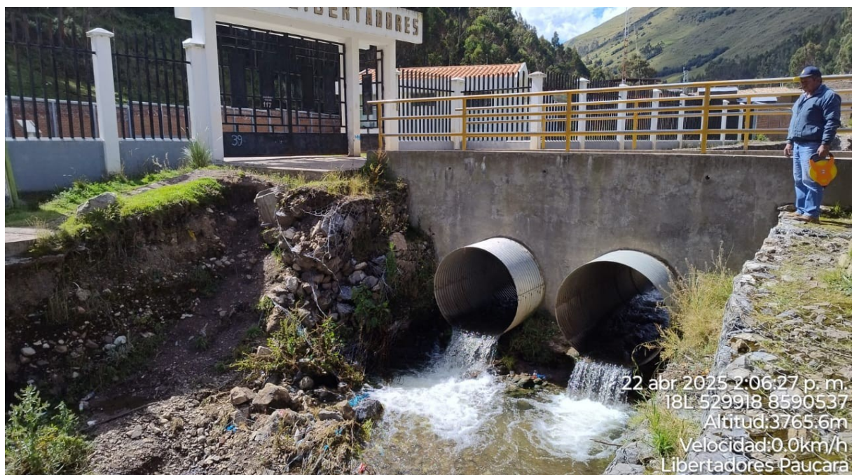
FIGURA N°03: PONTON TIPO ALCANTARILLA QUE IMPIDE EL PASO DEL CAUDAL MAXIMO QUE ES DE 17.52M3/SEG
